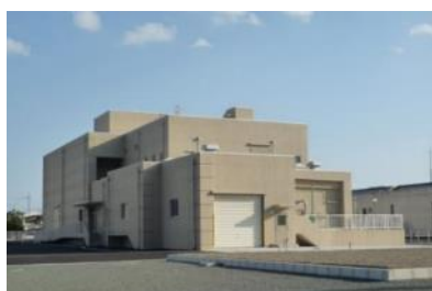
【長谷ポンプ場の整備】
