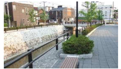
一の坂川周辺整備
