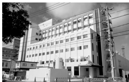
令和4年9月に供用開始した 済生会山口総合病院 北棟
