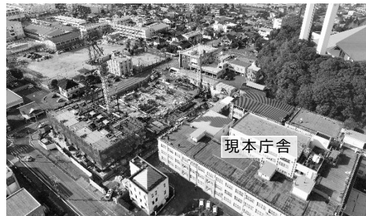
建設工事中新本庁舎(令和5年12月時点)
