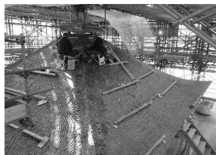
五重塔5層目の屋根の葺き替え作業
