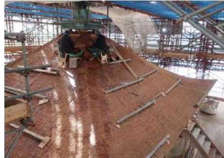
五重塔5層目の屋根の葺き替え作業
