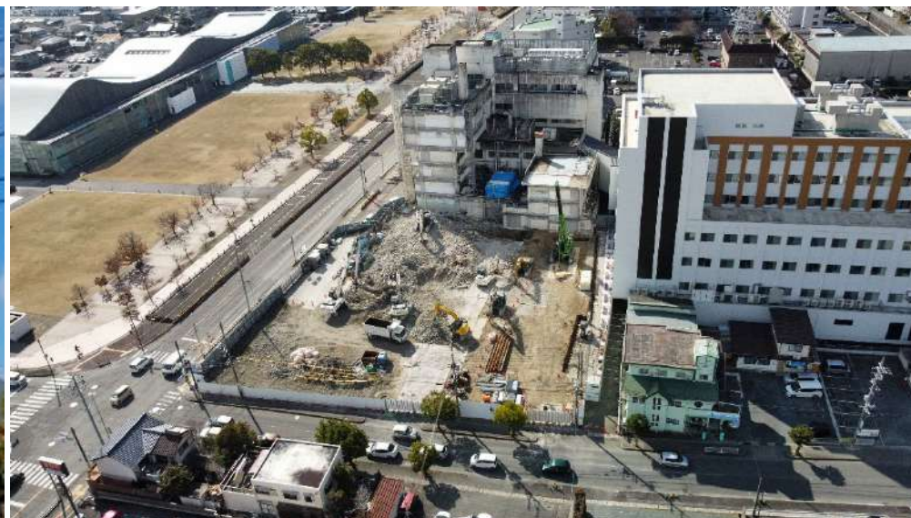
解体工事中の病棟（南棟建設予定地）
