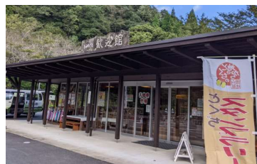
② 歓迎館看板⇒修繕活用
