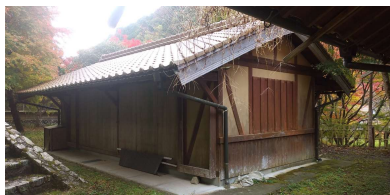
⑯-2 白波横作業場⇒改修
