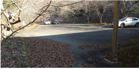
③⑩ 職員駐車場⇒修繕活用
