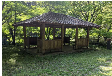
⑧ 東屋2 ⇒修繕活用
