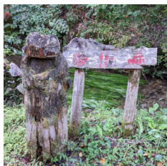
②8夢広場サイン⇒撤去
