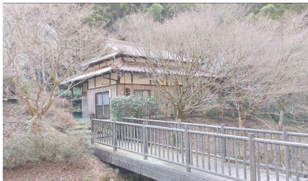
⑨ 厠・多目的家屋 ⇒解体・植栽
