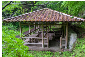
㉙ 東屋3⇒解体
