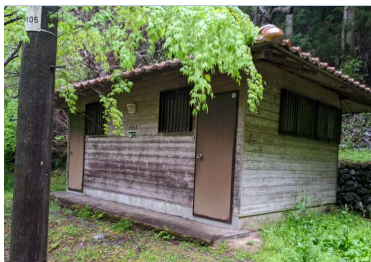
㉘ トイレ⇒解体
