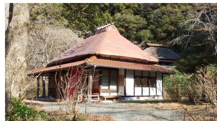
⑫ 重源茶屋 ⇒解体・植栽
