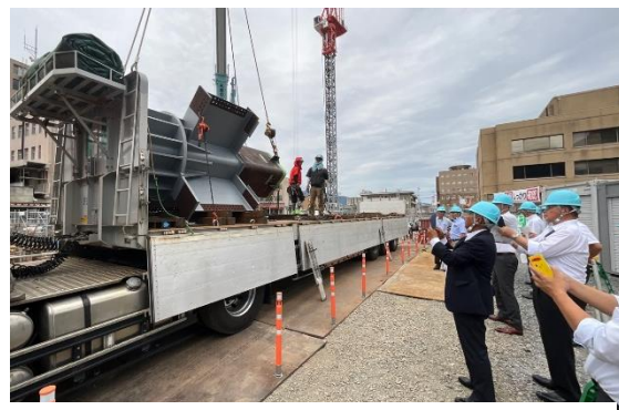
【免震装置設置の様子（防府市）】
