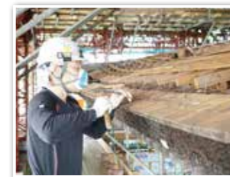
▲軒付の裏板を取り外す様子
