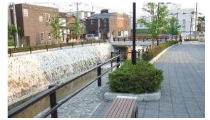
一の坂川周辺整備
