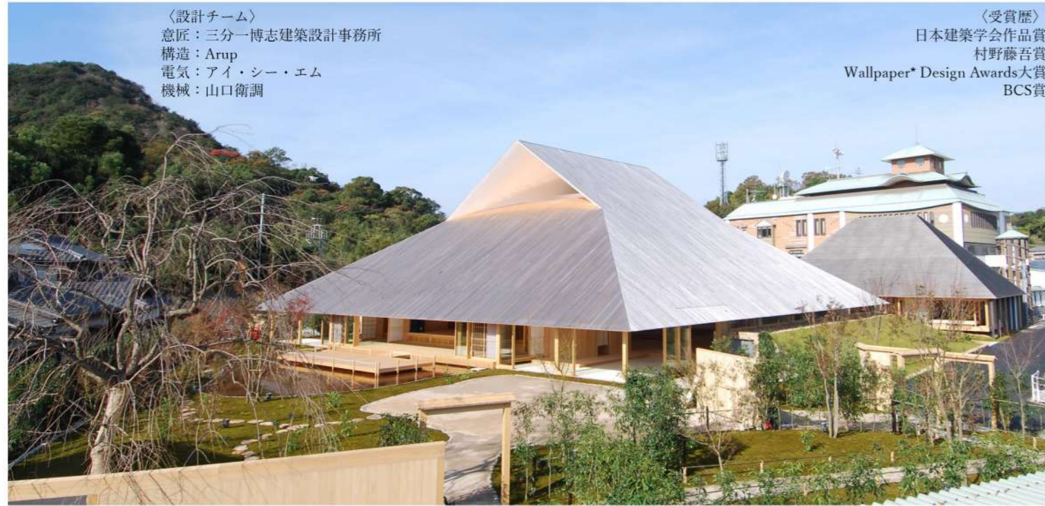
●ホール外観: 直島の卓越風の風向に即して入母屋屋根に開けられた風穴を、直島の風が通り抜ける
