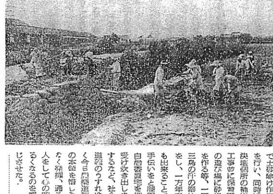
阿知須町の農道が、飛石郡落石の被害に遭った
