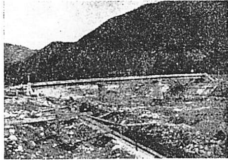
(写真上 間方橋と護岸工事の状況)
