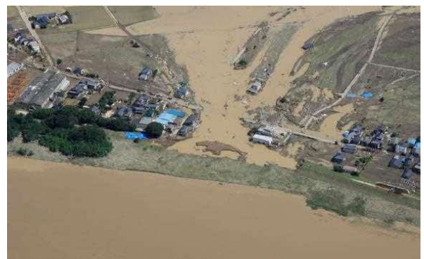
堤防決壊による家屋の流失(鬼怒川)
