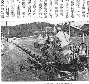
写真は河内の工事現場(24日撮影)
