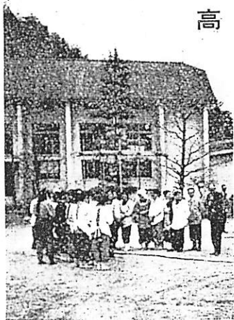
写真は、消防ポンプの操作訓練
