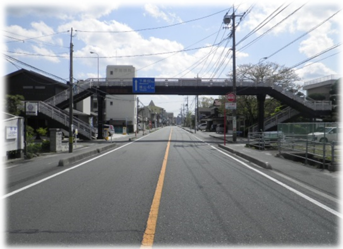
柳井田津市線横断歩道橋（やないだついちせんおうだんほどうきょう） 1966年12月 竣工
