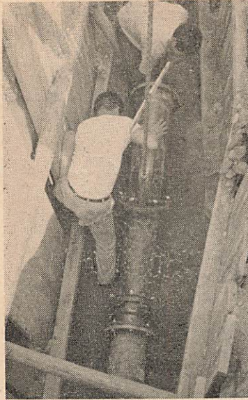
周辺部への幹線パイプの施設作業がすすめられています
