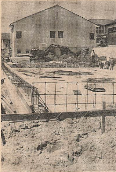
夏休み前にオープンをめざして、急ピッチでプールの建設作業をすすめています（興進小）
