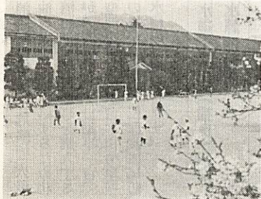
改築される大殿小学校
