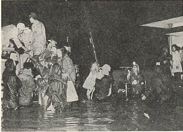
「背中が冷たくなったので目がさめた。気がついたらたたみの上まで水が来ていた」……47年7月災害は集中豪雨の恐ろしきを見せつけました(避難する大内御堀地区住民)
