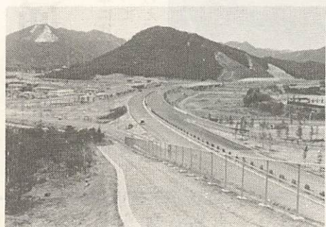
写真は上から小郡バイパス（名田島付近） 山口宇部有料道路（今坂インターチェンジ） 中国自動車道（山口インターチェンジ） 右は、山口縦貫道、のうちの県道山口徳山線（仁保坂本付近）
