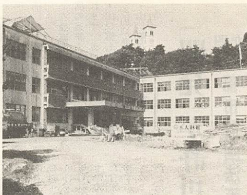
消防庁舎は新築するもので、鉄筋三階建一千五百二十七平方
