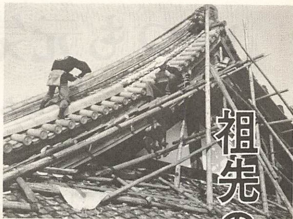
重要文化財竜福寺の 避雷工事と屋根の修理工事
