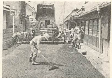
市道の舗装率は百パーセントに近い
