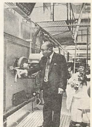
清掃工場の火入れ式
