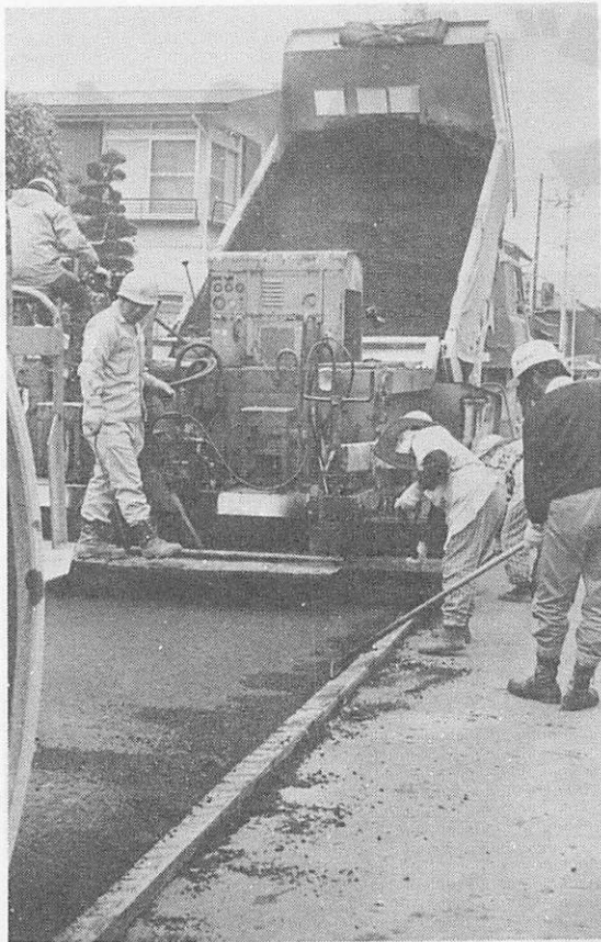
快適な生活環境づくりのためには、市道の整備も重点目標の一つです。舗装率は87%ですが、幹線から庭先までが最終目標、年間110万㎡舗装しています。
