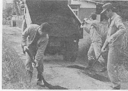
交通事故に直結するような緊急穴ポコ補修は、市職員が直接実施しています。
