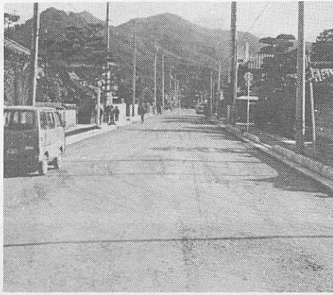
舗装工事を待つばかりになった石観音・伊勢橋線、今八幡宮前から国道9号をのぞむ。
