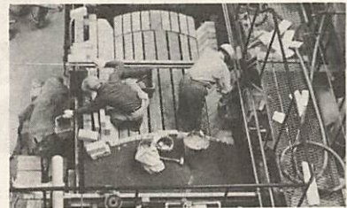
焼却炉の耐火レンガのとりかえ工事
