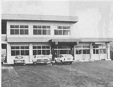
ほぼ完成した陶出張所・公民館の外観。クリーム色の鉄筋コンクリートの建物は、堂々とし、まさにコミュニティの館にふさわしい建物です。
