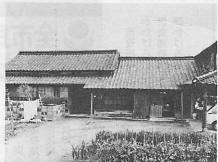
軒の低い本屋に作業場を併設した昭和集落の昭和の初めの建物
