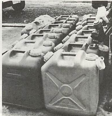
ガソリンの運搬が禁止されている20リットル入りポリ容器
