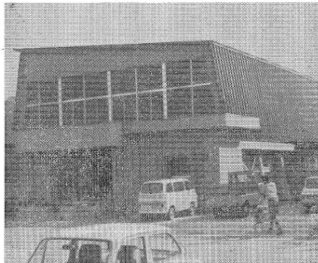
写真は中央公民館大会議室の全容
