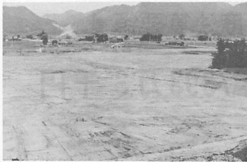
造成工事を終わった 大内の市民運動広場
