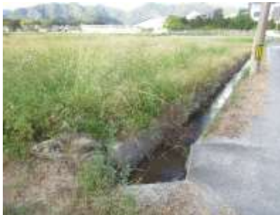
雨水排水路(史跡指定地外・東側)
