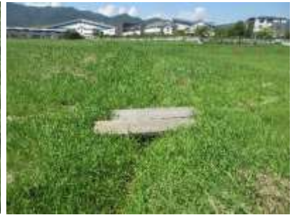
史跡指定地内の雨水排水路
