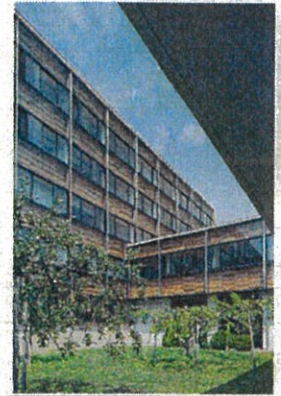
青森県庁舎 耐震・長寿命化改修
