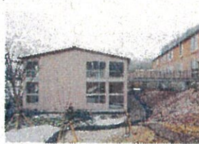
釜石市立唐丹小学校・釜石市立唐丹中学校・釜石市唐丹児童館
