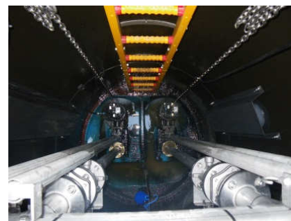
マンホール内部
