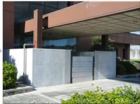
防水壁(パネル設置時)
