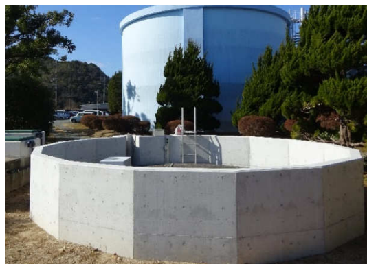
宮島水源地の防水壁
