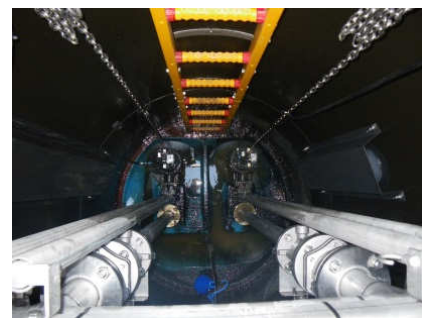
マンホール内部
