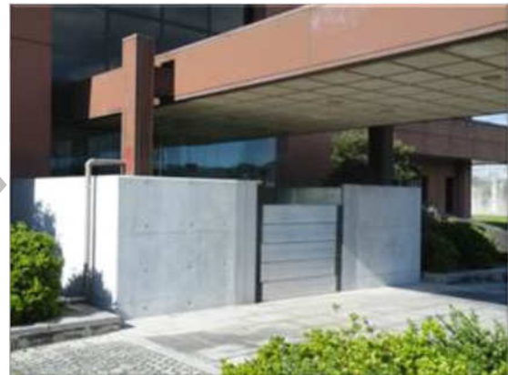
防水壁(パネル設置時)
