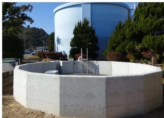
宮島水源地の防水壁
