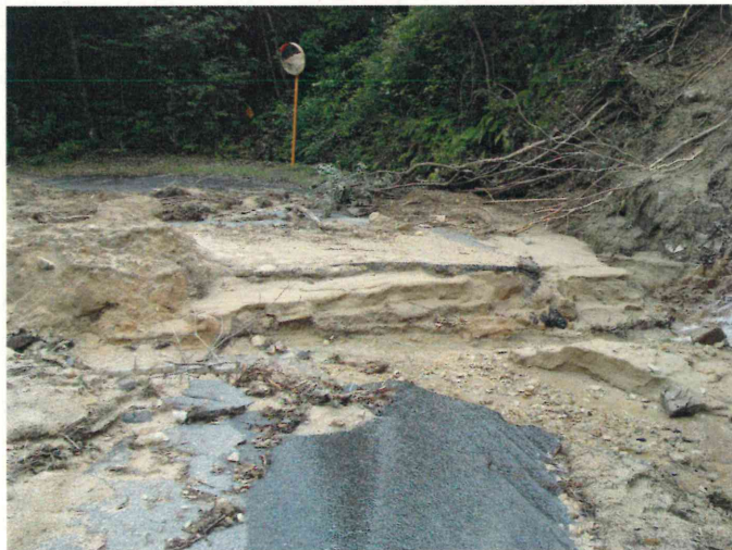
写真 市道一貫野16区線
