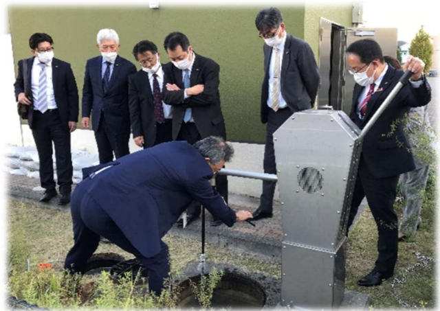
マンホール型防災トイレ設備の確認の様子
