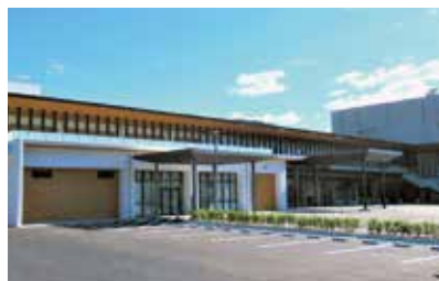
完成した阿知須総合支所（上）と徳地総合支所（下）の外観
