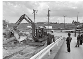
消防活動用重機の移動実技
