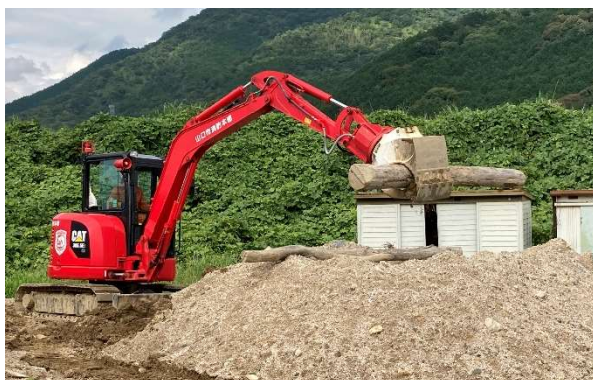
重機による堆積物除去作業
