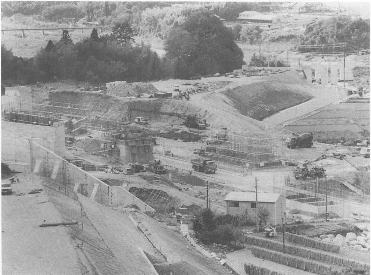
▲工事が進む徳地インターチェンジ (10月30日写す)
