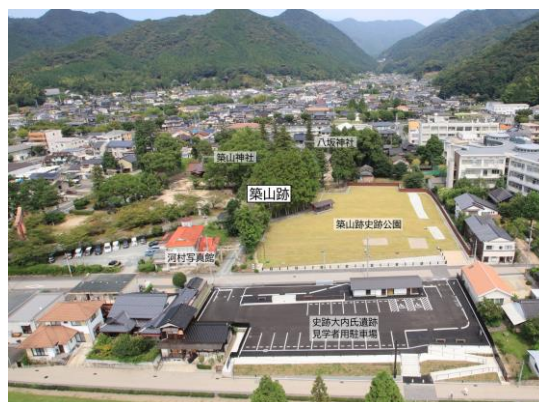
築山跡の整備 令和4年10月10日「築山跡史跡公園」オープン予定
