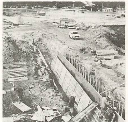
市民の総合運動場として完成が待たれる工事中の市民運動広場
