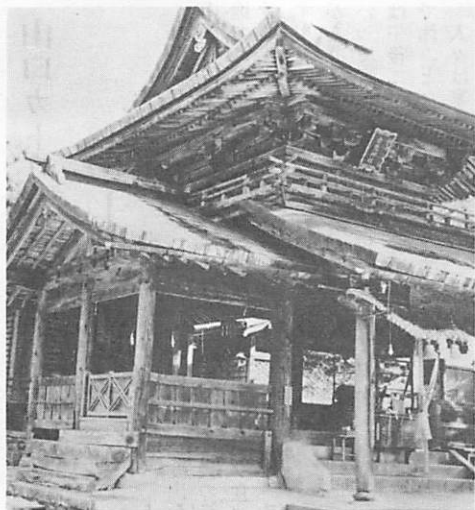
古熊神社拝殿は、室町時代の楼門造りの様式をよく伝えている建物で、昭和24年に国から重要文化財に指定されています。近く、この拝殿は、解体修理される計画です。
