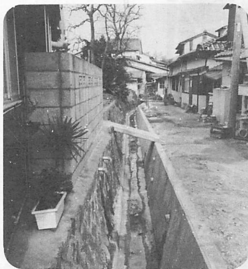
改修を終わった宮野・森ヶ坪水路。住宅地の間をぬうように走る水路の改修がすすめられます。
