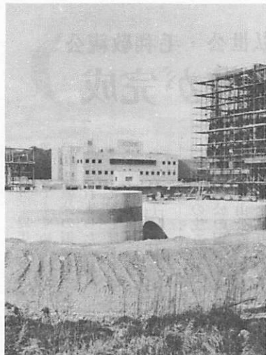
＜下水道浄水センター＞ 57年度供用開始を旨として建設がすすんでいる浄水センター。汚れた川がきれいになる日が近づきます。
