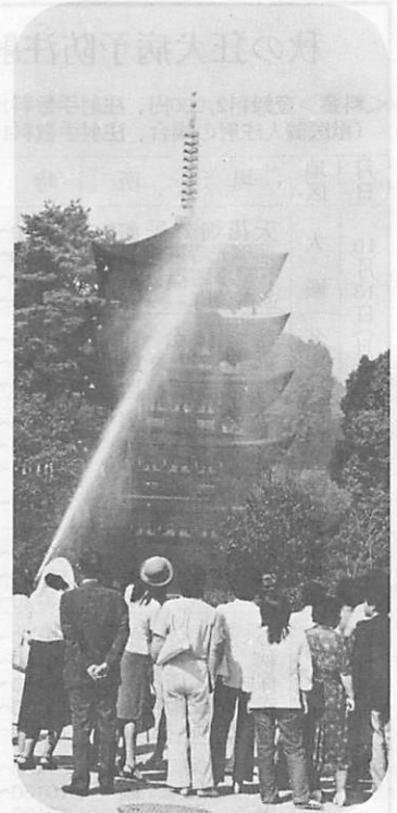
国宝五重塔に消火設備などが完成。今年二月から工事を進めていた瑠璃光寺五重塔の防災設備が完成、九月十二日、塔を取り囲むように設置した四基の放水銃のテストなどが行われました。
