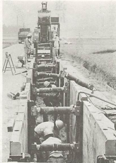
秋穂町で始まった400ミリの送水管埋設工事。工事中は片側通行になります
